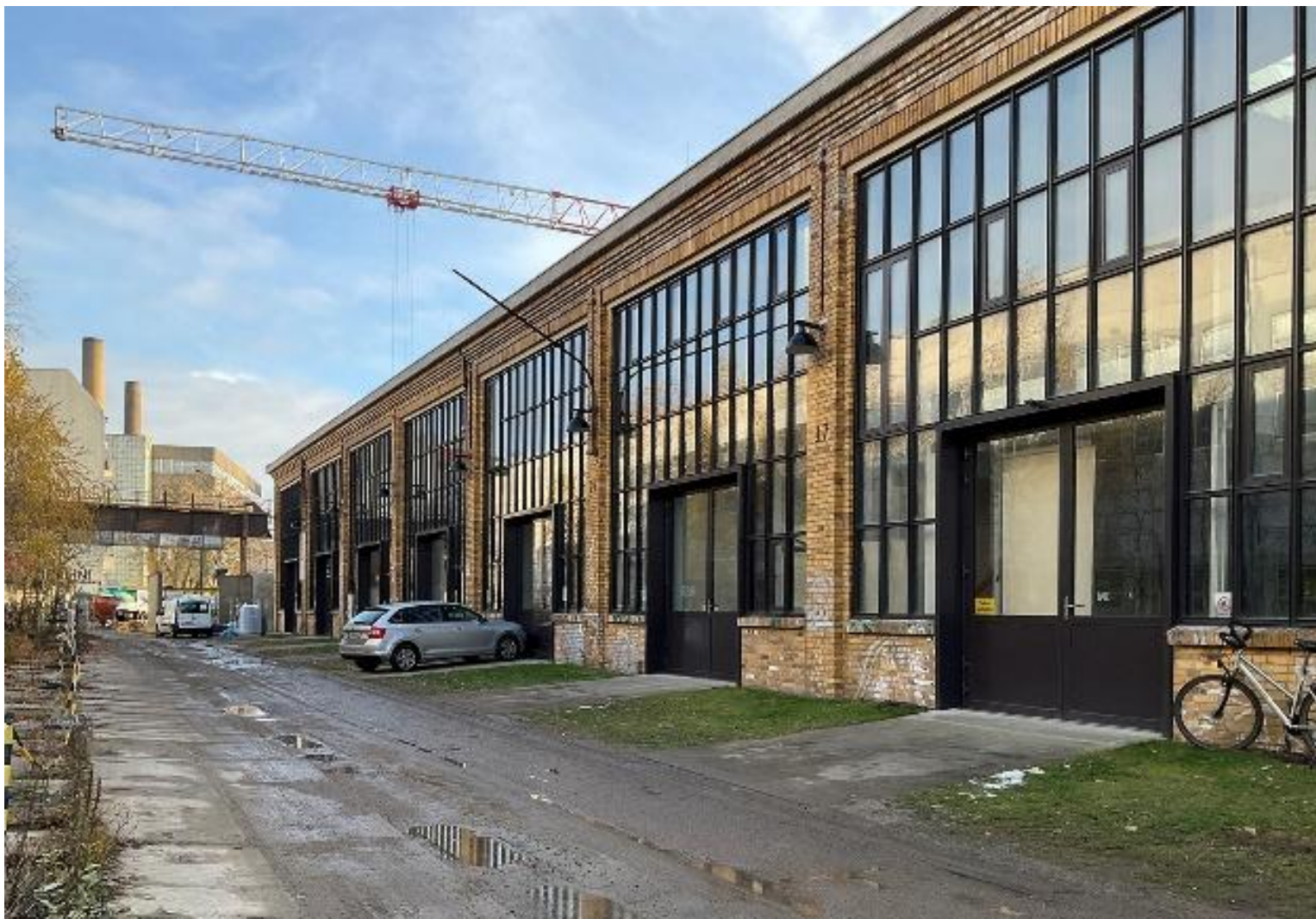
建物側面の1区画にある財団事務所、奥に印刷・版画工房。
